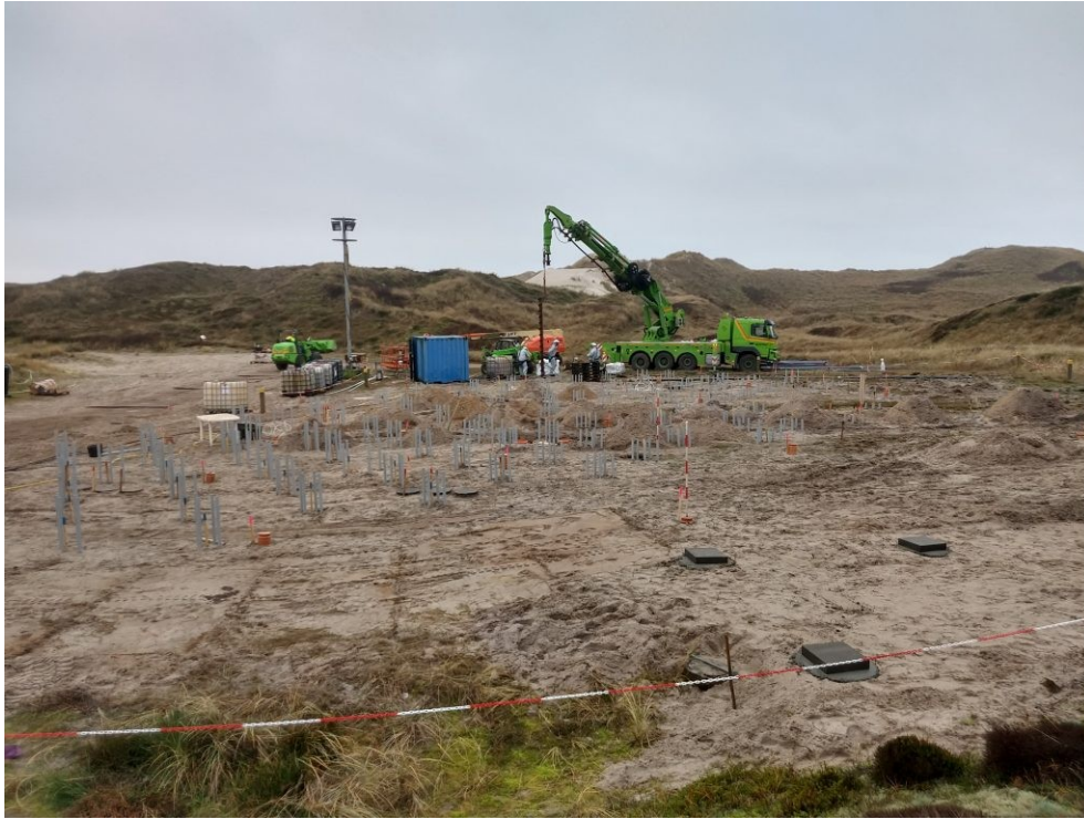
Site contamin  de K rg rd sur la c te ouest du Danemark (ancienne fosse   d chets pharmaceutiques). Photo prise en 2019 lors de l'installation de l'infrastructure pour la d pollution des eaux souterraines par traitement biologique et chimique in-situ (L a L vy).
