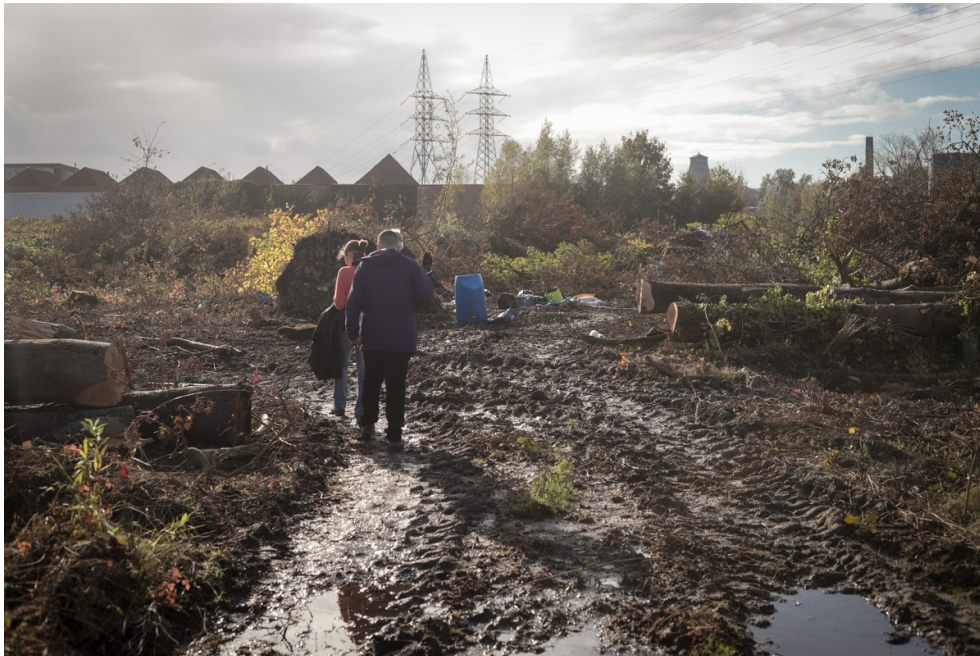
Arbres coupés, traces dans la terre humide... Les engins de chantier ont dévasté le lieu. © Théo Heffinck / Reporterre
