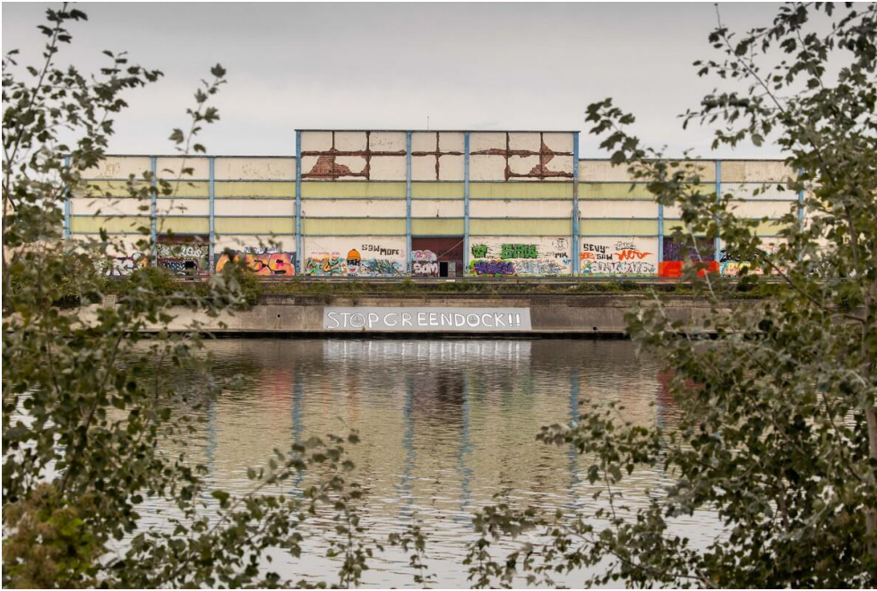
Malgré l'opposition, les travaux de démolition de ces hangars à l'abandon ont débuté. © Mathieu Génon / Reporterre
