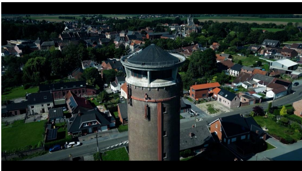
Château d'eau de Chièvres © RTBF
