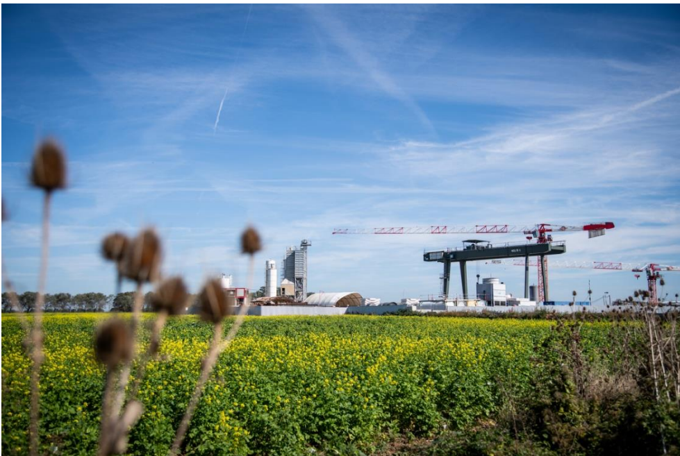
Les travaux de la future gare de la ligne 17 ont déjà commencé. Ici, le 1 er octobre 2023. © NnoMan Cadoret/Reporterre
