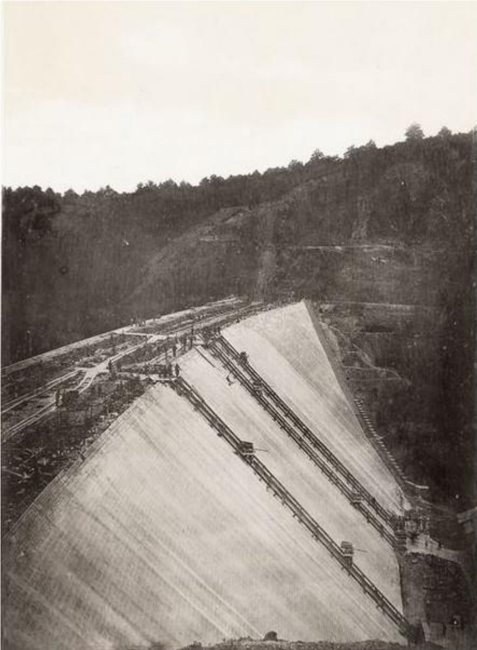
Travaux du barrage de la Gileppe. Vue du mur barrage Amont [s.n.], ca. 1867 – 1875 – Archives KBR.
