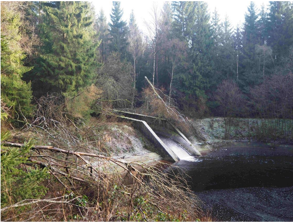
Bassin d'arrivée du détournement de la Vesdre vers le lit de la Steinbach. Photo par l'auteure.
