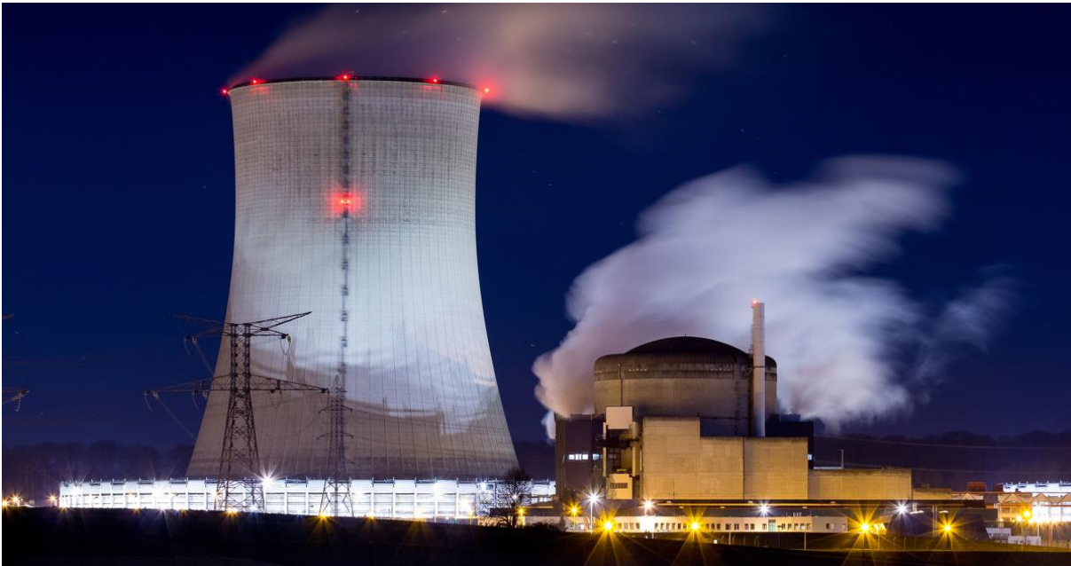
© Laurent. Centrale de Cattenom où une des fissures a été découverte.
