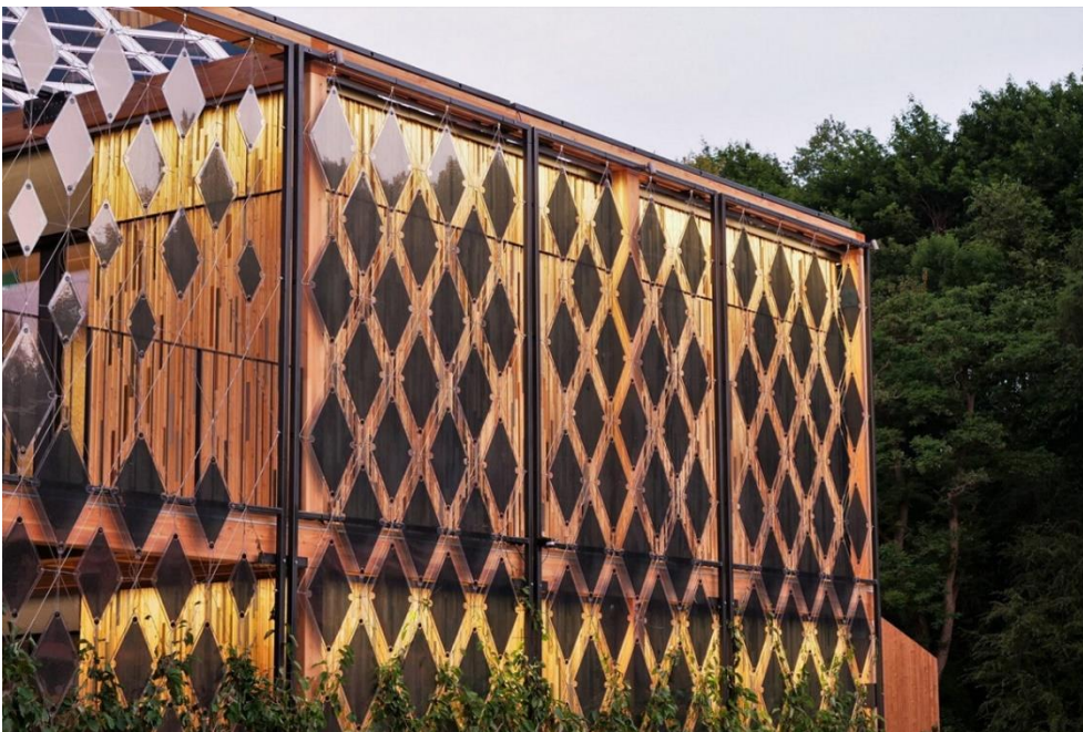
Des panneaux solaires modulables intégrés dans un maillage métallique. Asca
