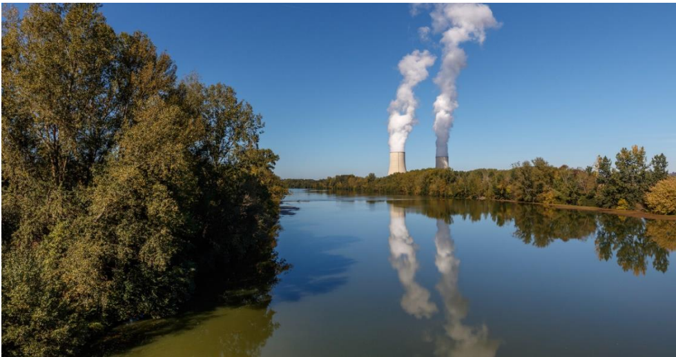
© thomathzac23. La centrale de Golfech, sur la Garonne.
