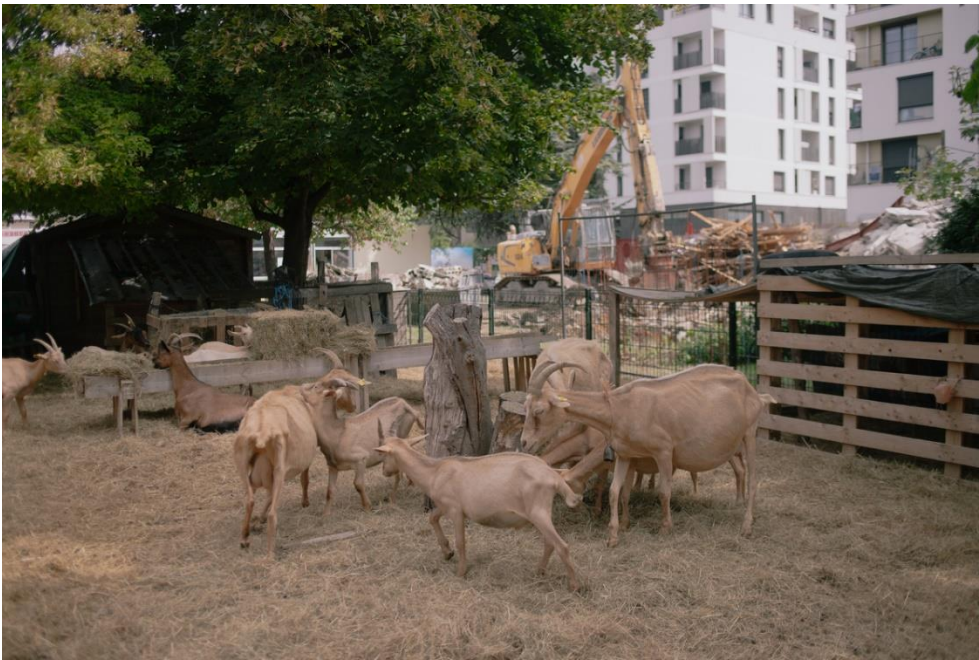
Les travaux ont commencé le 11 juillet 2022. ©Cha Gonzalez / Reporterre
