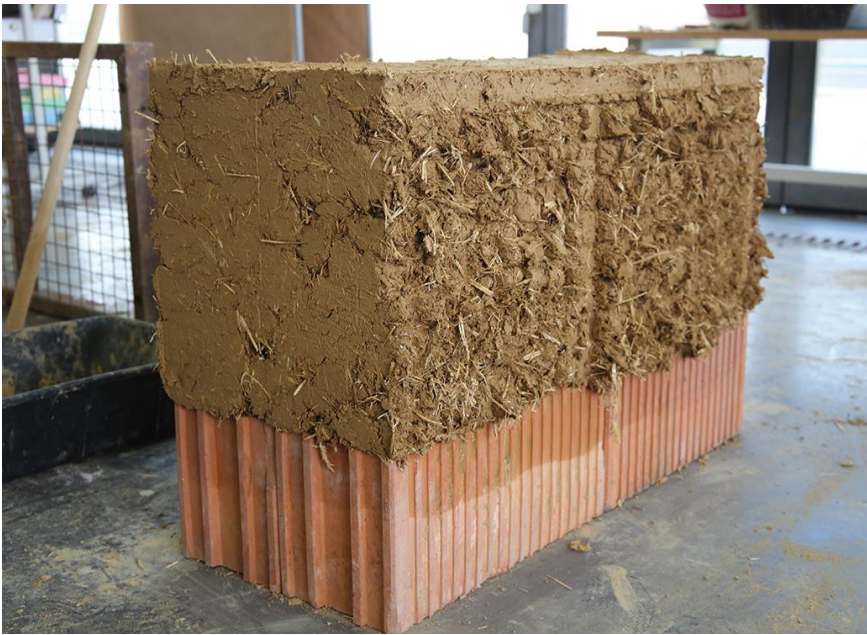
Début d'un mur de bauge.
