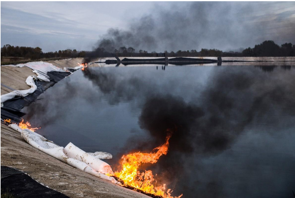
Une bassine avait été endommagée en Charente-Maritime, le 6 novembre 2021. © Corentin Fohlen/Reporterre
