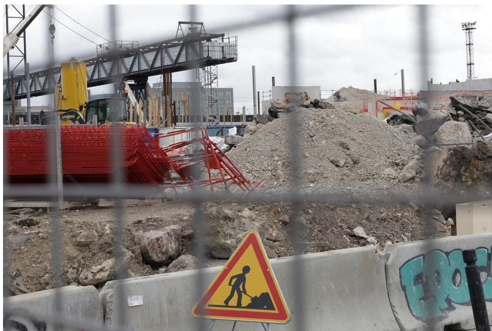
Chantier du Grand Paris
