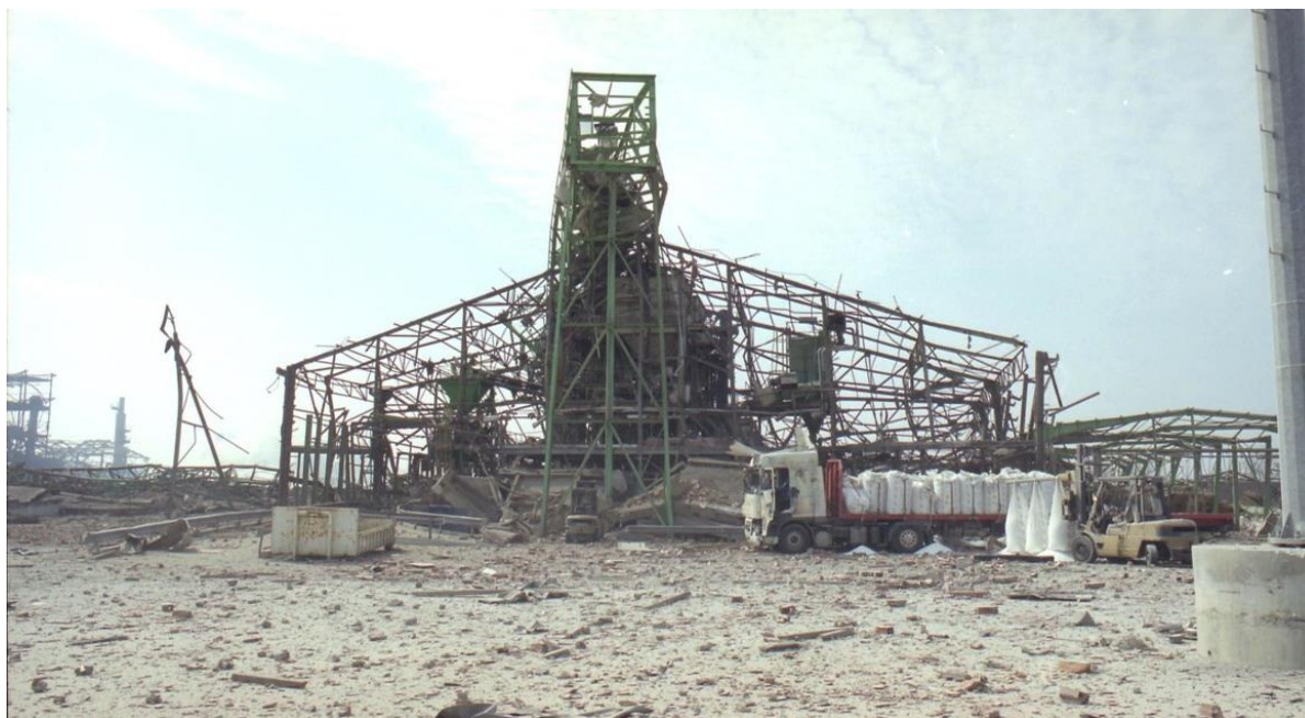
© Ville de Toulouse. Le 21 septembre 2001, le souffle de l'explosion dans l'usine AZF de Toulouse provoquait de nombreux dégâts.
