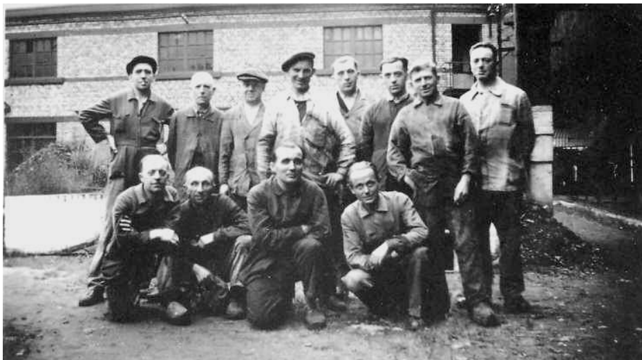
Ougrée-Marihaye: M. Soquette et ses compagnons, derrière le train à feuillards, vers 1942 (photo M. Soquette)
