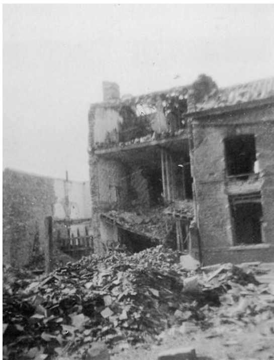
Maison détruite de M. Degey, rue Dejardin, à Sclessin-Ougrée (photo Commission Historique de Cointe-Sclessin & Fragnée)
