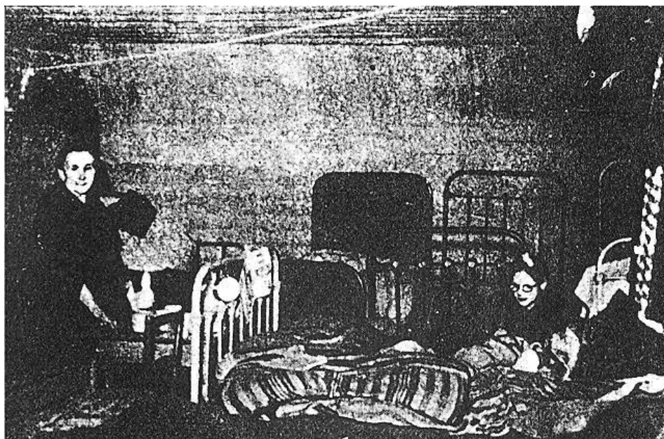
Installation confortable dans les piles du grand pont de Sclessin pendant la période des robots (document Commission Historique de Cointe-Sclessin & Fragnée)
